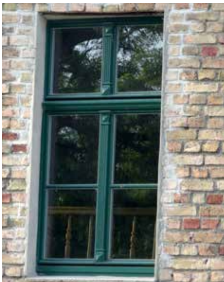
Stulpfenster mit vier Fensterflügeln in Liepe
