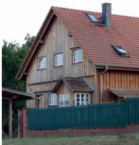
Holzfassade an einem Neubau in Niederfinow
