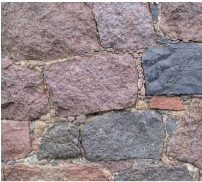
Feldsteinmauerwerk in Zyklopenbauweise
