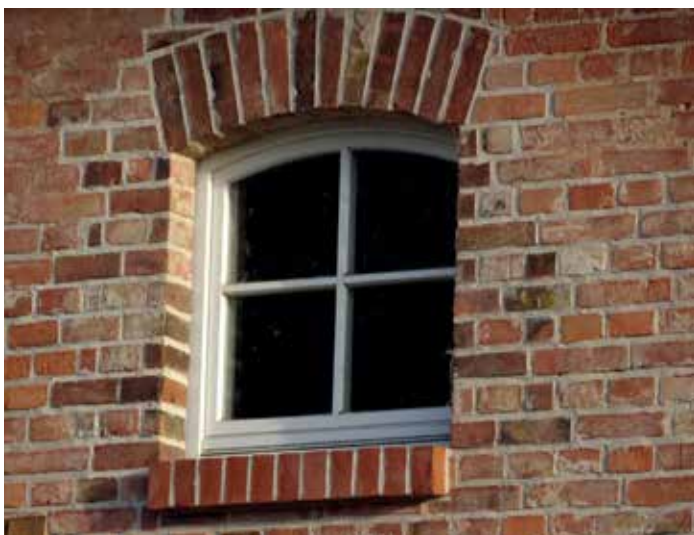
Holzfenster in Liepe, passend zum Ziegelmauerwerk
