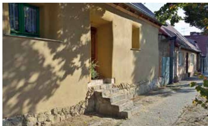
Innovativer Neubau in Strohballebauweise auf alten Feldsteinfundamenten mit massiven Granitblockstufen am Eingang in Joachimsthal
