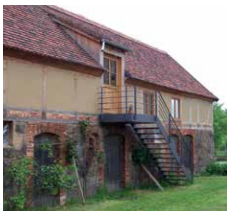
Lehmfassade an einem zum Ferienhaus umgebauten Stallgebäude
