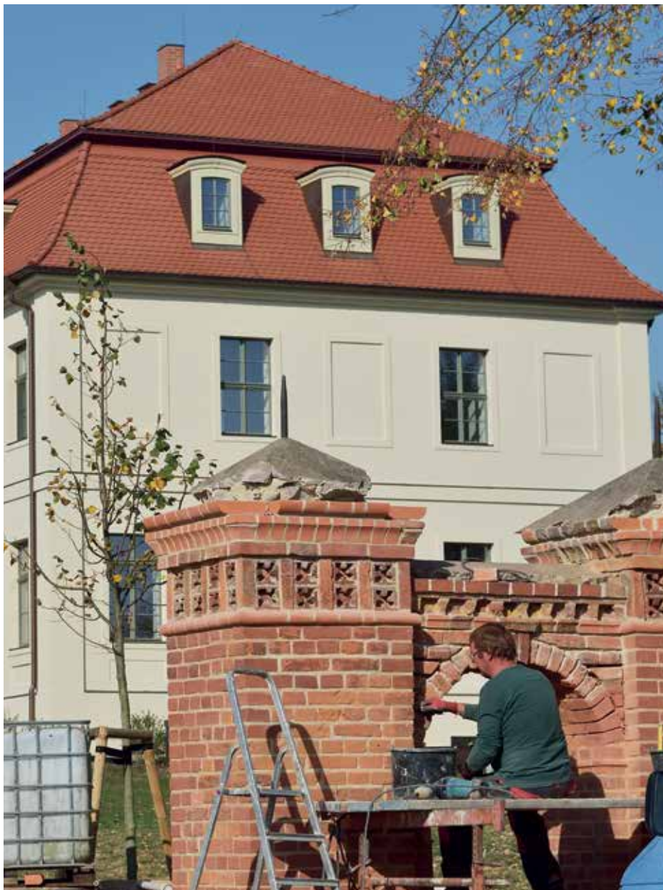
Sanierung des Eingangstores zum Gutshaus Groß Fredenwalde
