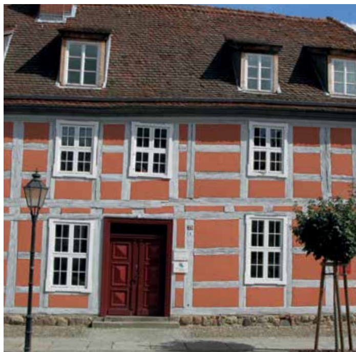
Handwerklich gut saniertes Fachwerkhaus in Angermünde
