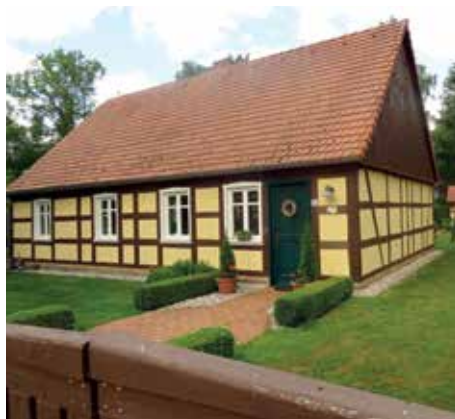
Historisches Fachwerkhaus in Bebersee
