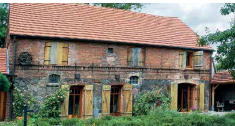
Regionaltypisch sanierter Altbau
